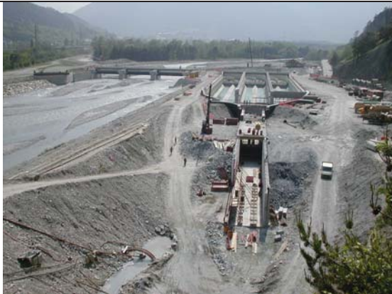
Particolare della diga con dissabbiatore
